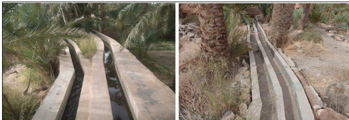
Photographie 15 : Canaux bétonnés (Janty, 2011)
