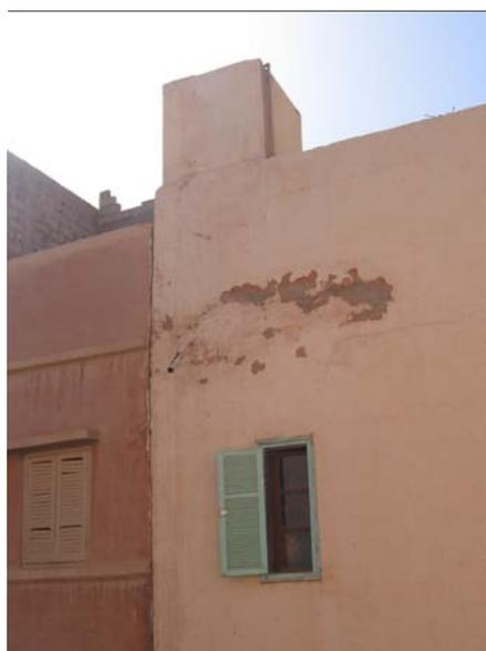
Photographie 45: Problèmes d'infiltrations sous un réservoir (Zagora)
