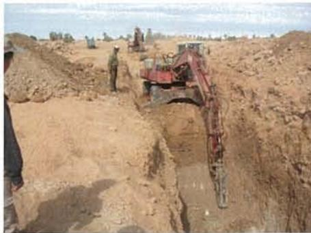
Excavation à ciel ouvert à la rétrocaveuse et au brise-roche
