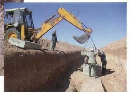
Puits en béton pré-fabriqués
