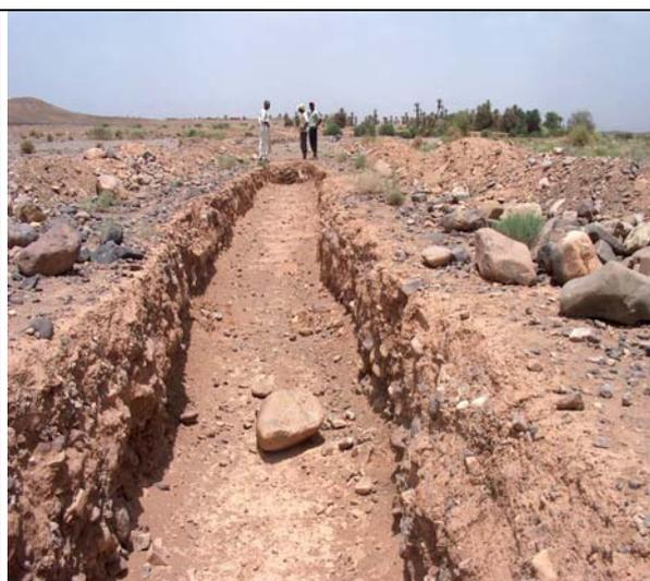
14: Traçage des travaux de creusement d'une Khettarat ( Ihandar, Ferkla El Oullia)
