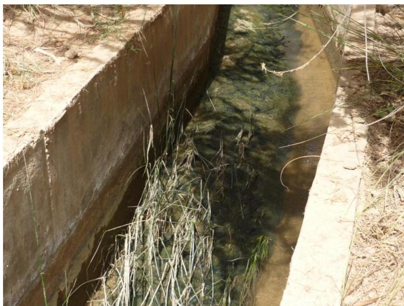
Photo 7. Séguia en béton non entretenue
