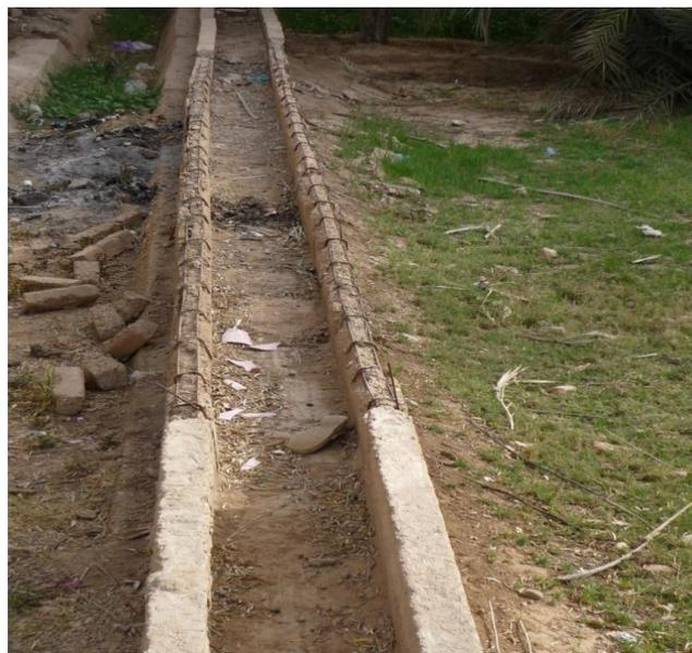
Photo 6. Séguia bétonnée en état détérioré
