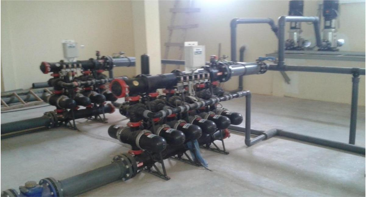
Figure 11 : Photo de la station de filtration à disques.
