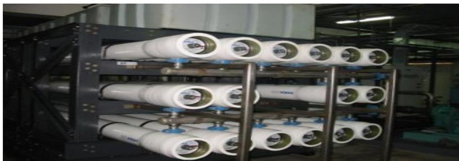
Figure 10: Rack de tubes de pression d'osmose inverse
