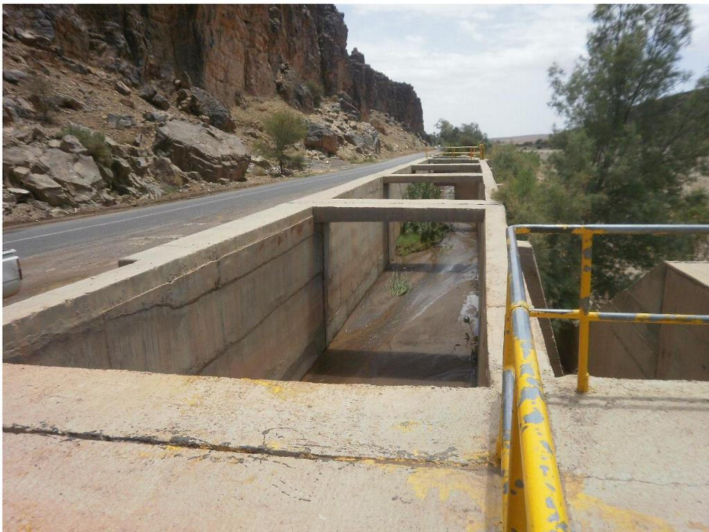
Figure 14: Séguia moderne de dérivation des eaux de crue à Tazarine
