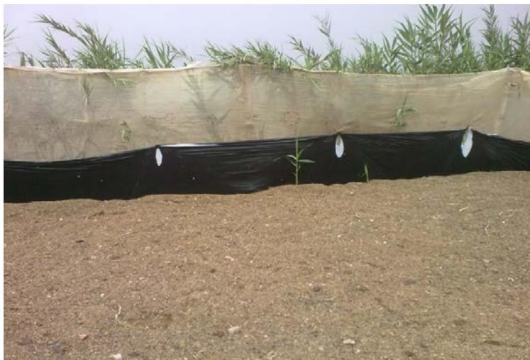
**Figure 14 : Imperméabilisation de la compostière C**
