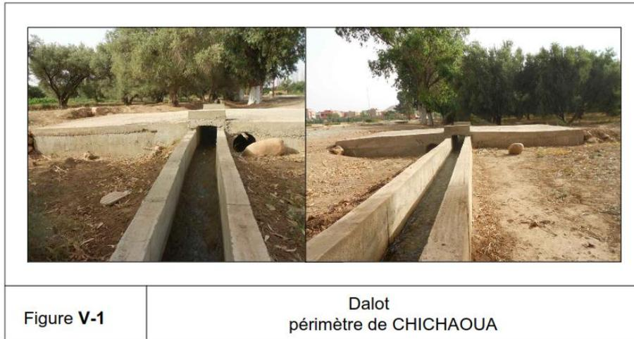
Hydrauliquement, le choix des raccordements du dalot au canal a une influence prépondérante dans le fonctionnement de l'ouvrage.
