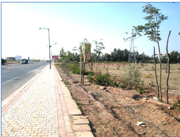
Alignement à l'entrée de Tamansourt
