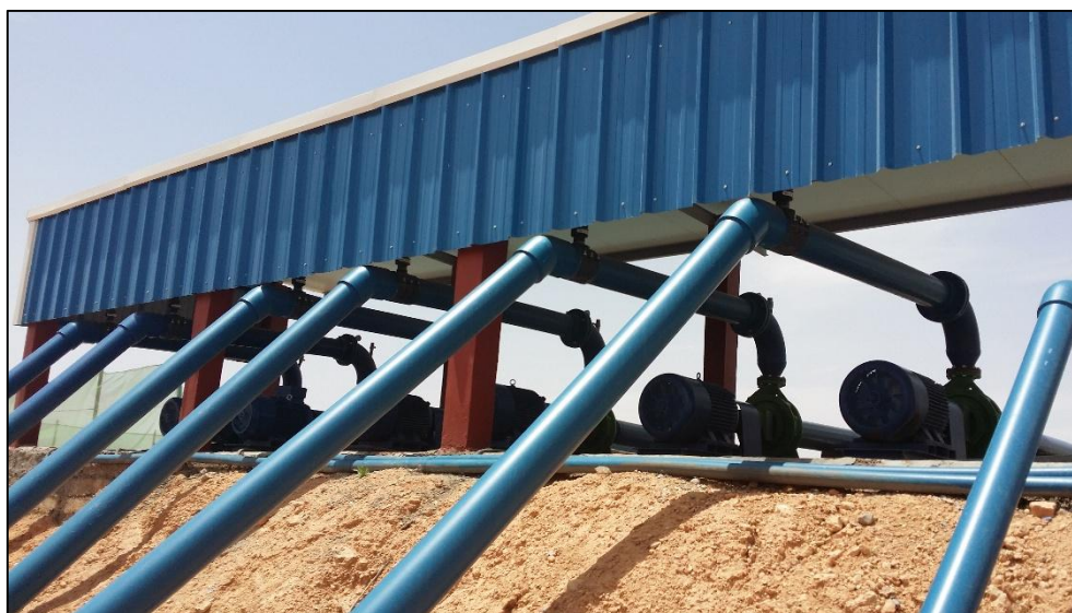
Figure 38. Pompes de refoulement à axe horizontal à partir d'un bassin dans une ferme très moderne
