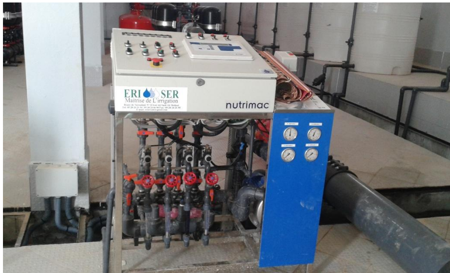
Figure 47. Kit d'injection de l'engrais
